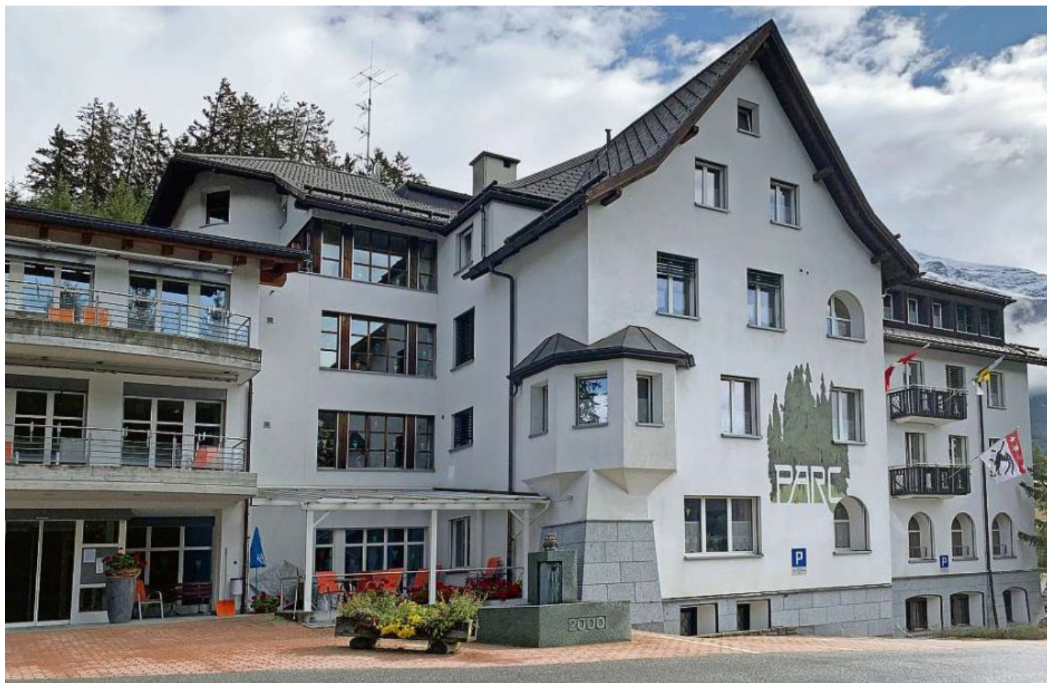
Der Neubau eines Seniorenzentrums ist derzeit blockiert.
